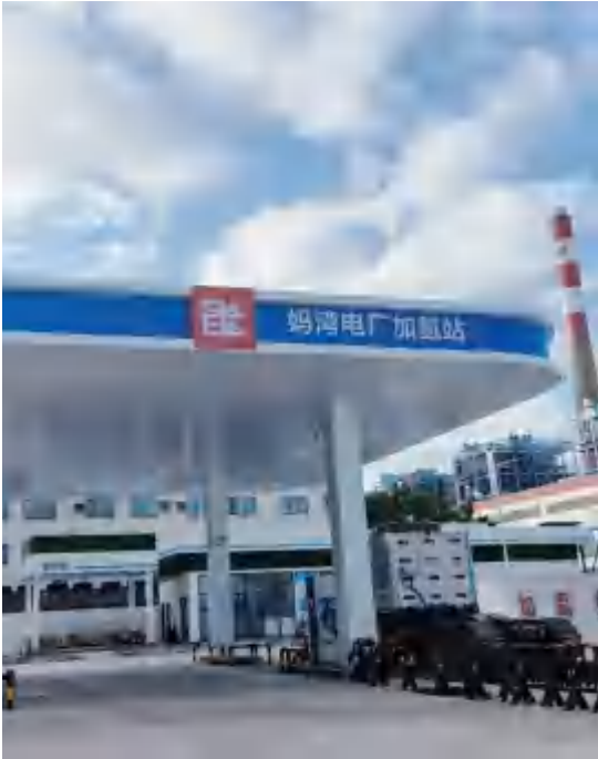
深圳能源集团妈湾电厂制氢加氢一体站
